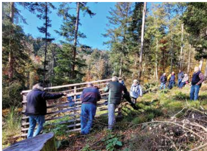
Installation d'enclos de protection
