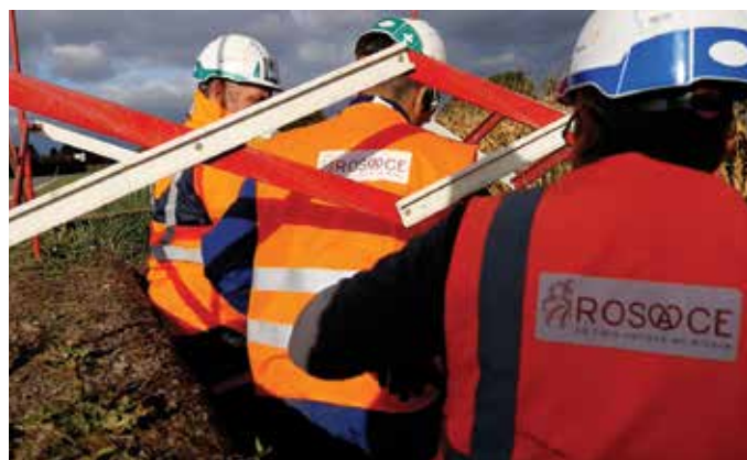
La société Rosace a été chargée du déploiement de la fibre optique dans plus de 700 communes en Alsace
